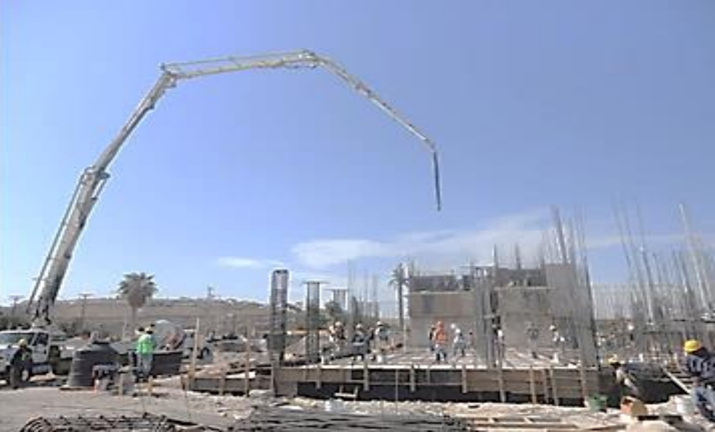
Construcción Hotel City express Cananea
