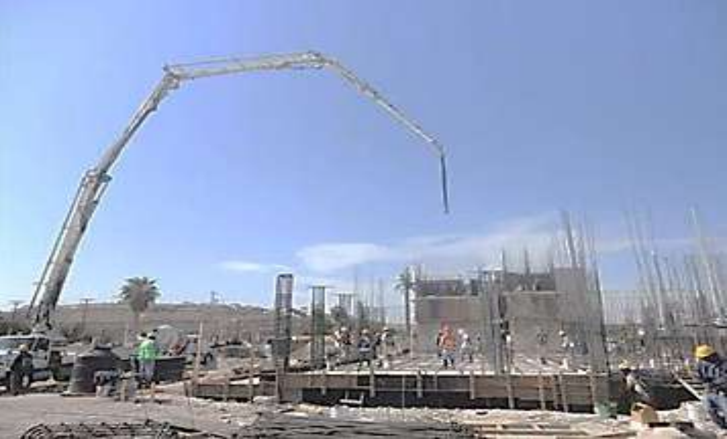
Construcción Hotel City express Cananea
