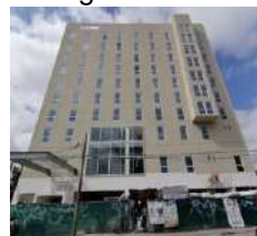
Ce Gdl. Galerías
