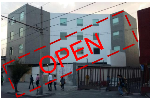
Ce CDMX Aeropuerto Open since April 2016
